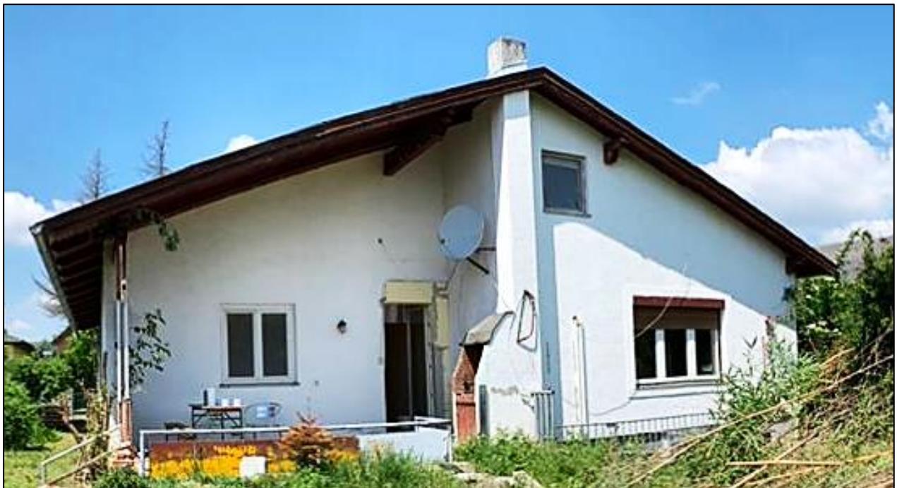
Grafik 18: Eigenheim 1220 Wien vor der Sanierung
