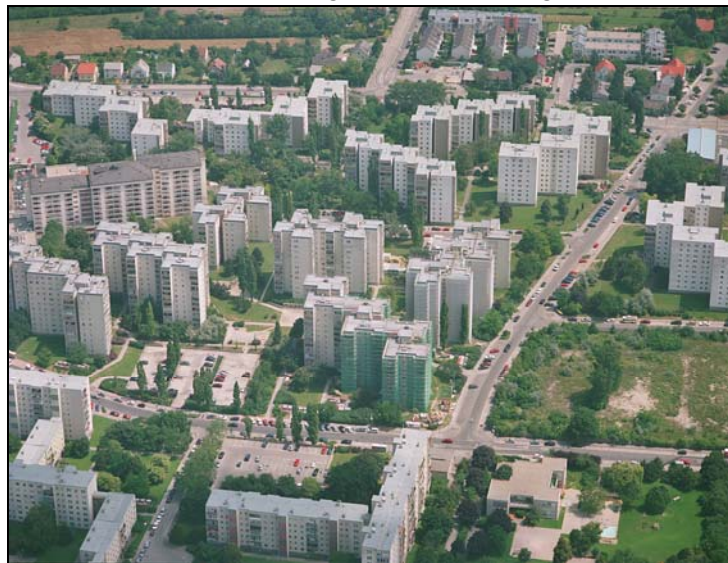
Darstellung 41: Luftaufnahme Lindenbauergasse / Mitterweg während der Sanierung
